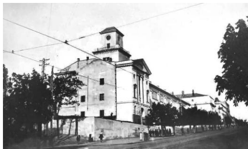
Рис. 1. Будівля ВУАН 1934 р., в яку після завершення будівництва у 1928 р. переїхав ЗМАН разом з більшістю інших академічних інституцій. Ця будівля була головною спорудою ВУАН до 1965 р., з центральним входом з протилежного боку (Короленка [Володимирська] 45), коли під 50-річчя СРСР почалася грандіозна розбудова АН з вивільненням будівлі під новостворений «Музей природи» (ЦНПМ, нині ПНПМ). Лівого крила і 5 (4) поверху в той час не було.
